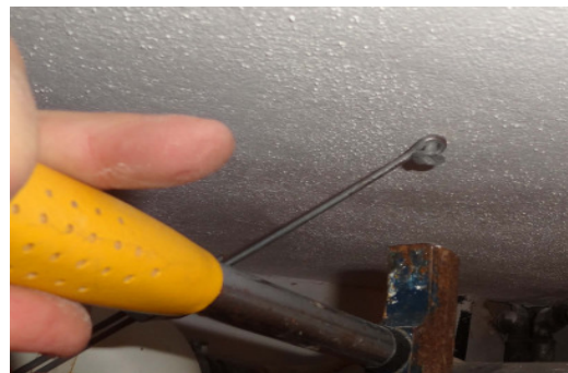
Bild 4: Nur einschlagen mit 4-5 Hammerschlägen,
