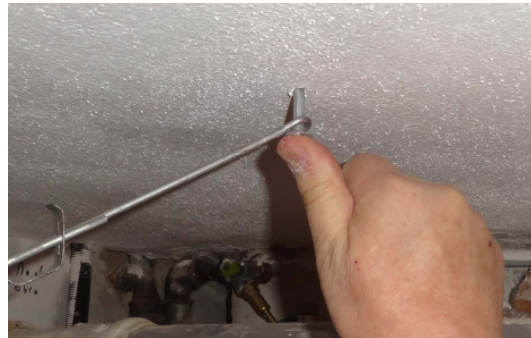
Bild 2: Den MND mit dem Daumen ins Bohrloch stecken...
