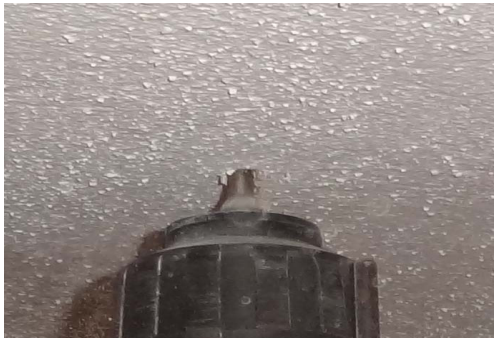
Bild 1: Ø 6 mm bohren – 48 mm tief, d. h. beim kurzen 6er-Bohrer hört da die Wendel auf.
